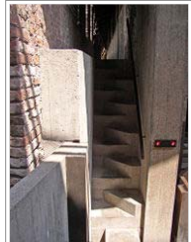
Carlo Scarpa - Scala sfalsata in Castelvecchio
