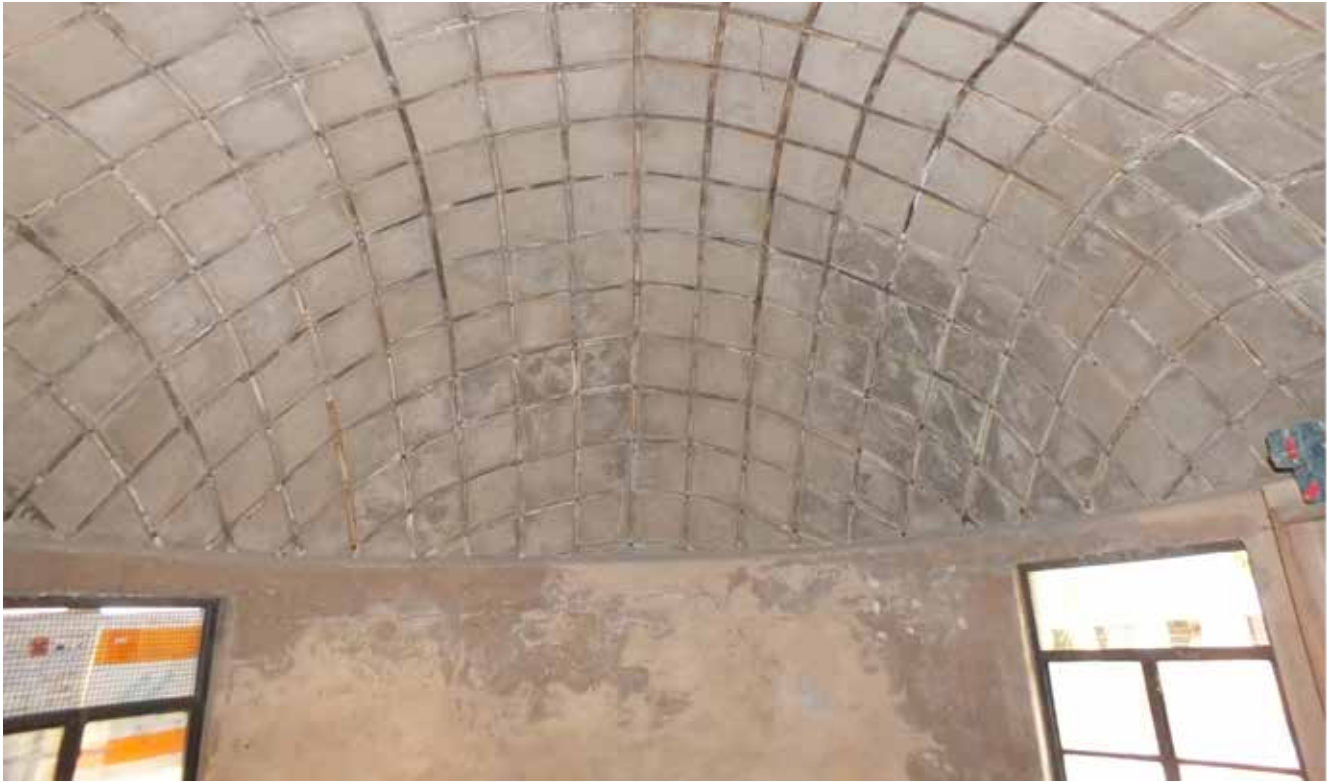
La volta di cemento gettata sulla griglia in bamboo (sinistra) e quella sulla griglia di tubi di acciaio (destra)
